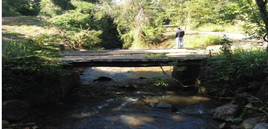
Para restabelecer o uso novamente da ponte, faz-se necessário a remoção do tabuleiro de madeira existente, ajuste das alturas e das alas. Se necessário devido ao ajuste dos acessos, prover a demolição de umas das cabeceiras e consequente reconstrução.
