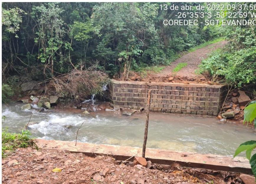
Para restabelecer o uso novamente da ponte, faz-se necessário o ajuste das cabeceiras, reconstrução de vigas de apoio ou ampliação da altura.
