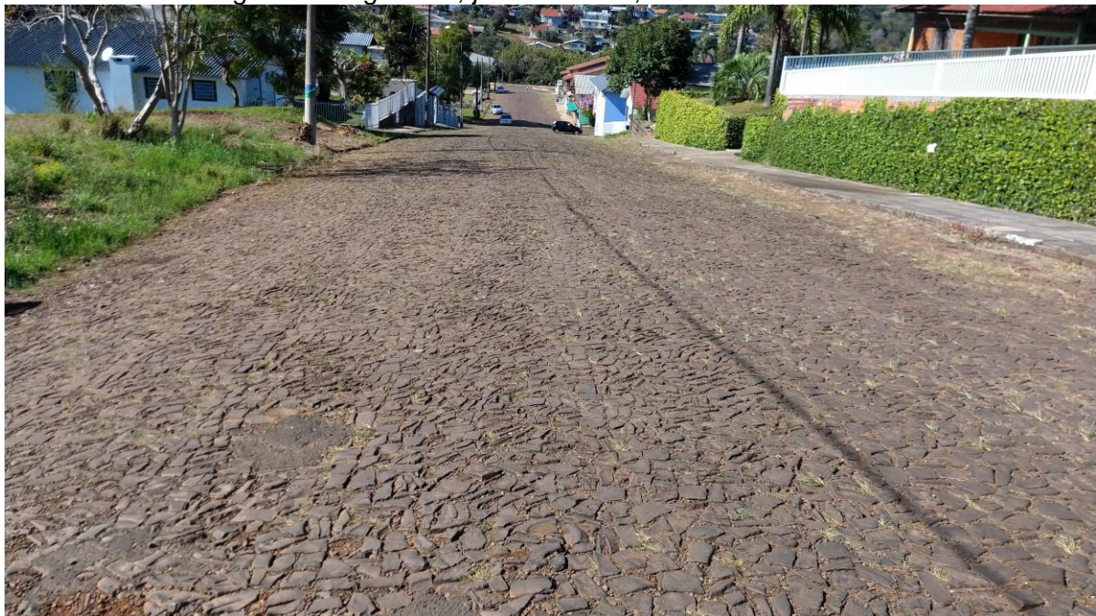
Registros fotográficos, julho de 2020, Rua Santos Dumont
